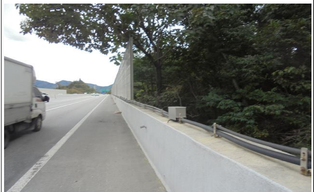
난간 및 연석 전경
