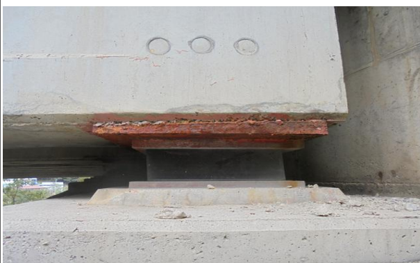
교량 받침 전경
